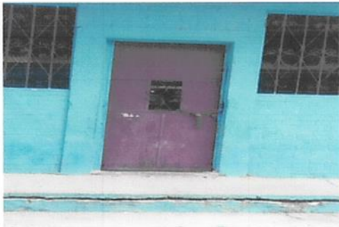
Foto 5: Reparación de puertas con pintura y cambio de chapas.
